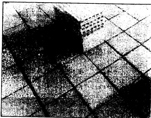
Foto N° 09 y 10: Vista de los Trabajos realizados en area de Tanque elevado, colocacion de ladrillo pastelero, tarrajeo interior.
